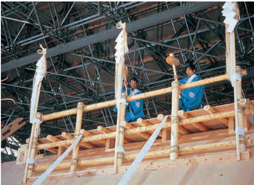
屋上の小工2人は「おー！」とこたえ棟木を2度、打ち固める。(内宮)
