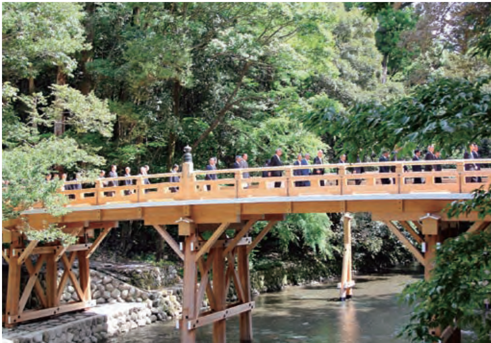
五十鈴川に合流する島路川にかかる風日祈宮橋。橋の上部はヒノキ材、橋脚には強度の高いケヤキ材を使用。長さ43.2m、幅4.6m、擬宝珠8基、橋脚3本立て5組(15本)、木除杭3本。
