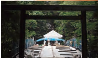
橋の敷板の加工には、船底を張るのと同じ船大工による伝統技法が用いられた。
